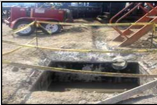
Foto 73. Zona de perforación, cunetas en tierra.
