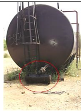
Fotos 70 y 71. Sistema de control utilizado para evitar contaminación por goteo de crudo de la válvula del tanque de almacenamiento.
