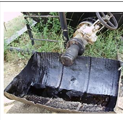
Fotos 70 y 71. Sistema de control utilizado para evitar contaminación por goteo de crudo de la válvula del tanque de almacenamiento.
